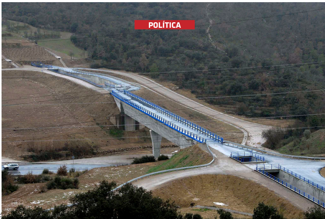
Túnel i pont del canal Segarra-Garrigues a l'altura de Ponts (Noguera).
