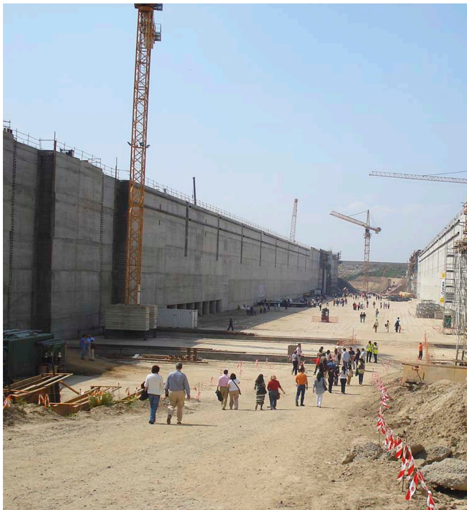
A Sevilla la UE i el BEI financen la construcció d'una nova resclosa, la més gran d'Europa.
