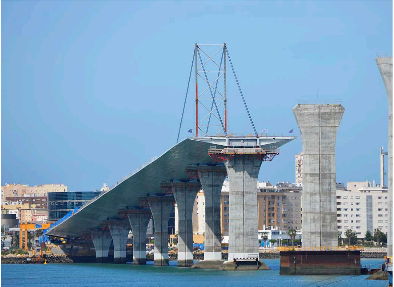
Actualment s'està construint un pont de cinc quilòmetres de llarg i de 500 milions d'euros a la badia de Cadis.
