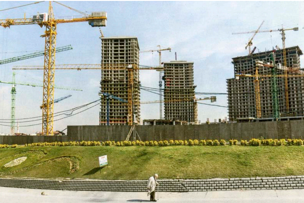
Centre comercial en construcció a Istanbul. “Tenim piles i piles de centres comercials. El sector que està més en auge és el de la construcció.” Ho diu Safak Çivici, una empresària de Kayseri.
