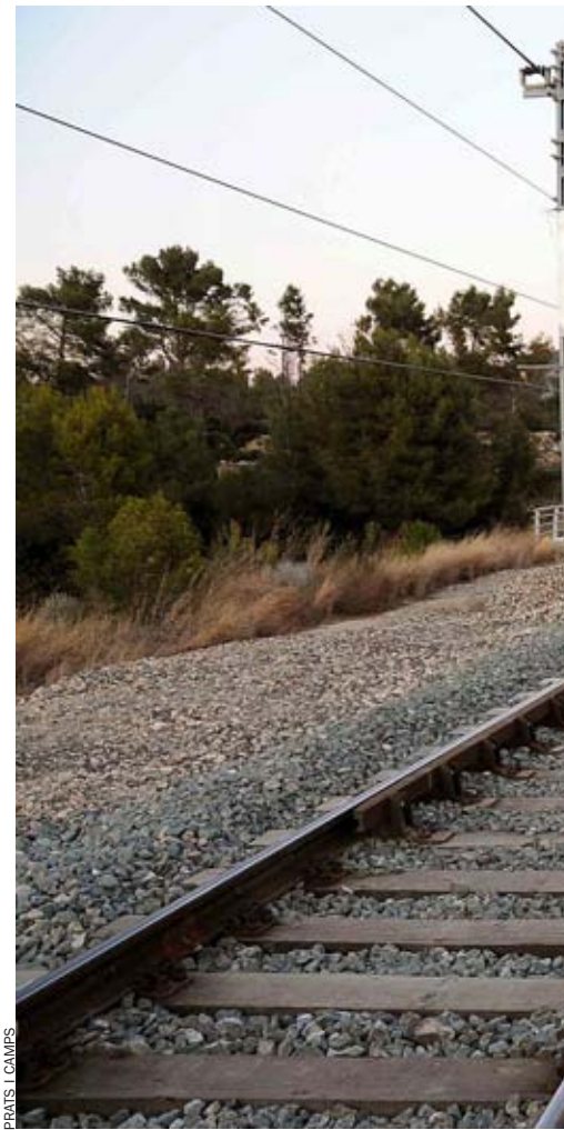
Foment ha començat a instal·lar ample ibèric
