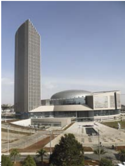
Edifici oficial de la Unió Africana, finançat i construït per Xina, a Addis Abeba, Etiòpia.
