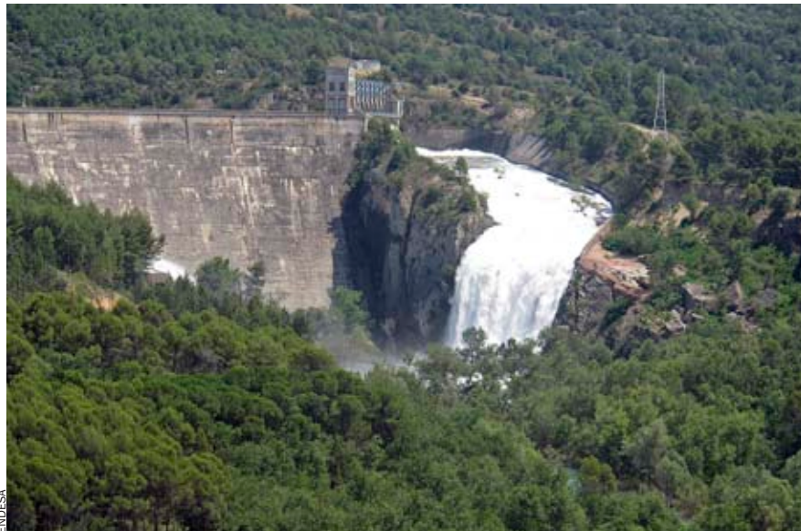
Les galeries de les preses, finestres laterals i edificacions auxiliars de les centrals hidroelèctriques d'Endesa a les conques de quatre rius catalans han esdevingut un cau per a ratpenats.
