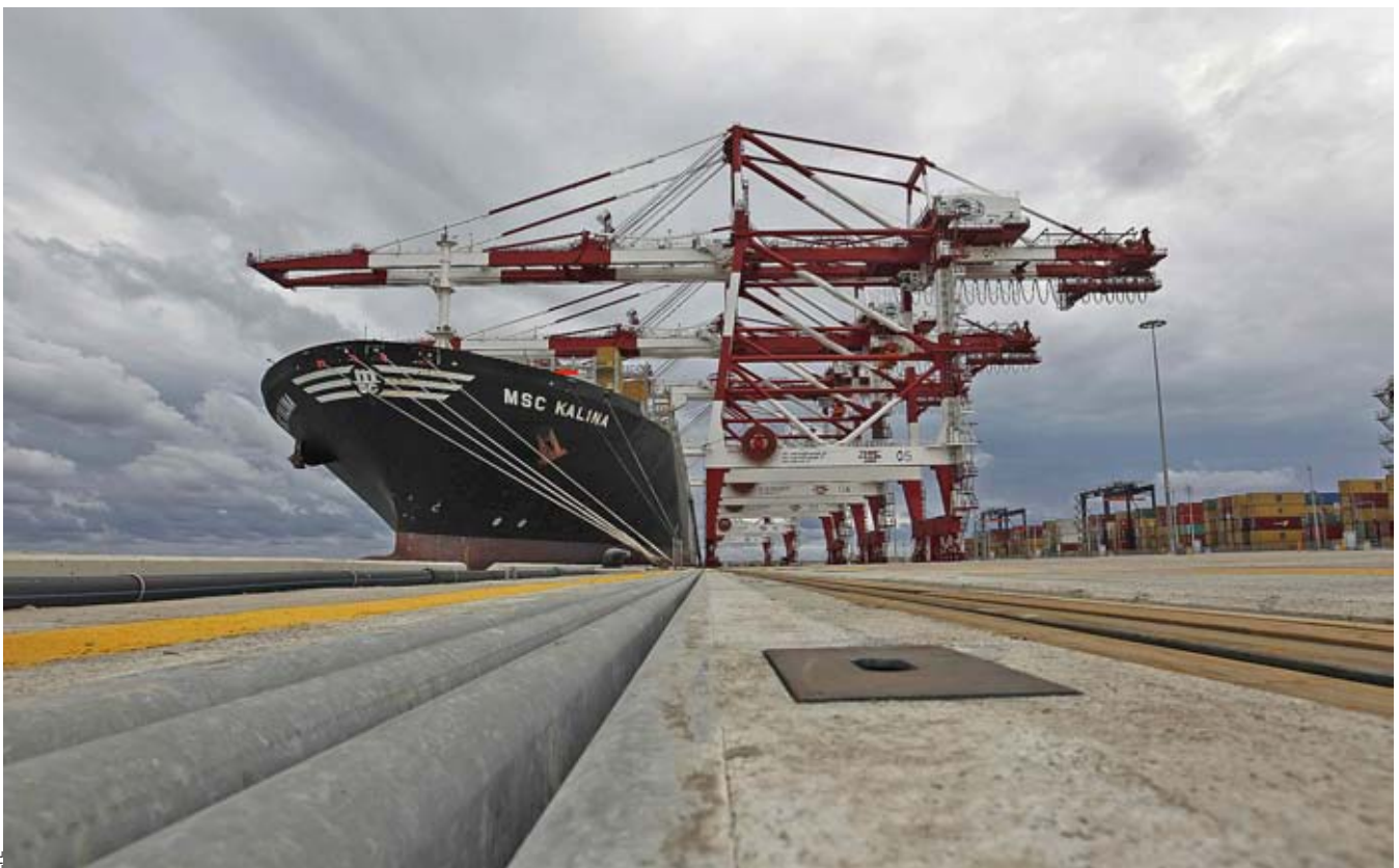
La nova terminal de contenidors del grup xinès Hutchinson al port de Barcelona. Va ser inaugurada el 27 de setembre del 2012.
