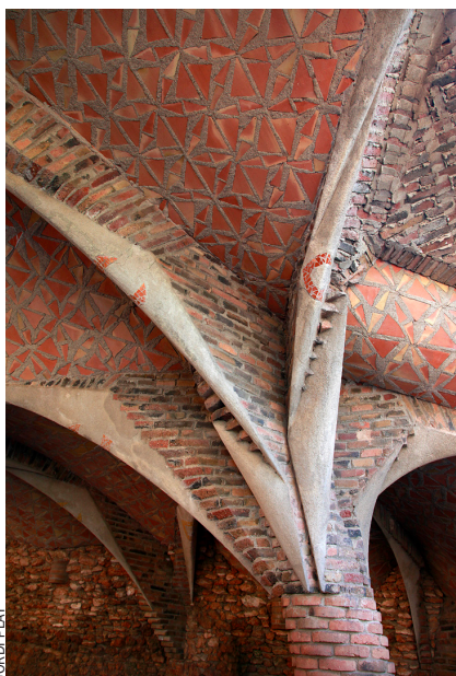
L'interior de la cripta de la Colònia Güell, amb les columnes de basalt portades expressament de Castellfollit de la Roca i una mostra (a sota) de com s'havien d'acabar sostres i nervis.
