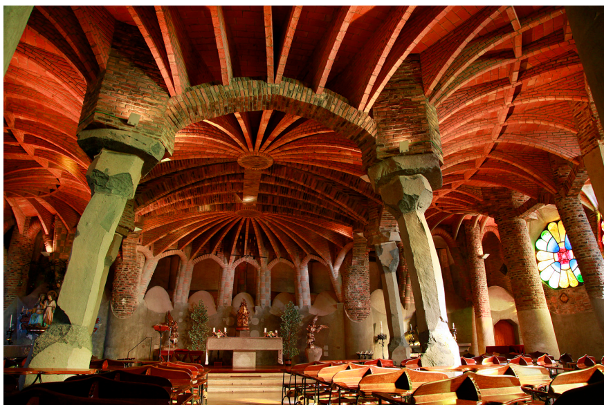
L'interior de la cripta de la Colònia Güell, amb les columnes de basalt portades expressament de Castellfollit de la Roca i una mostra (a sota) de com s'havien d'acabar sostres i nervis.
