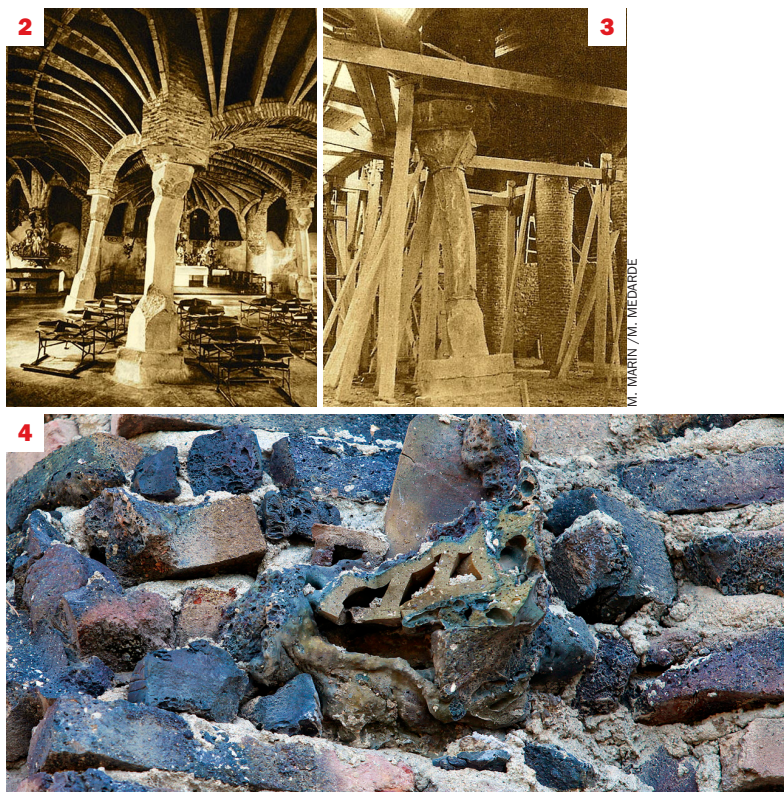
1. El trencadís està fet amb rajoles d'enderrocs d'obres, entre els quals vidres de iogurt Danone i cervesa Damm. 2. Dues pedres calcàries de la fàbrica de ciment dels Güell al Garraf li serveixen per a construir l'altar de l'església. 3. Les estructures de fusta que apuntalaven les columnes mentre eren en obres també es reciclaven. 4. Les parets de la cripta són majoritàriament d'un totxo recremat de les bòbiles, de gran resistència. 5. Per a la porta de la sagristia, aprofita els troncs d'eucaliptus que ha utilitzat com a pivots per a les bastides. 6. Per a les reixes, en forma de rusc d'abella, utilitza l'acer de l'eix de les selfactines de la fàbrica tèxtil, que és pràcticament inoxidable i flexible. Al cap de cent anys, es conserven intactes.
