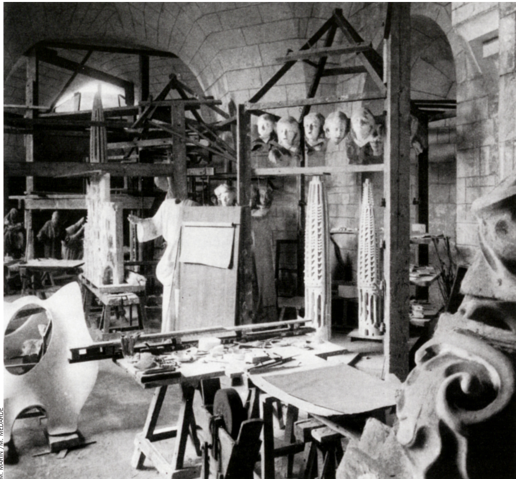
L'estudi on Gaudí treballava les maquetes de les seves construccions. Aquí va inventar la maqueta polifuncional, que li permet estudiar l'estabilitat de l'església representant-ne l'estructura.
