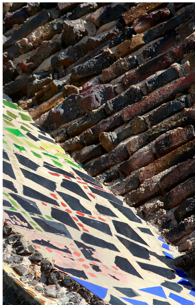
1. El trencadís està fet amb rajoles d'enderrocs d'obres, entre els quals vidres de iogurt Danone i cervesa Damm. 2. Dues pedres calcàries de la fàbrica de ciment dels Güell al Garraf li serveixen per a construir l'altar de l'església. 3. Les estructures de fusta que apuntalaven les columnes mentre eren en obres també es reciclaven. 4. Les parets de la cripta són majoritàriament d'un totxo recremat de les bòbiles, de gran resistència. 5. Per a la porta de la sagristia, aprofita els troncs d'eucaliptus que ha utilitzat com a pivots per a les bastides. 6. Per a les reixes, en forma de rusc d'abella, utilitza l'acer de l'eix de les selfactines de la fàbrica tèxtil, que és pràcticament inoxidable i flexible. Al cap de cent anys, es conserven intactes.
