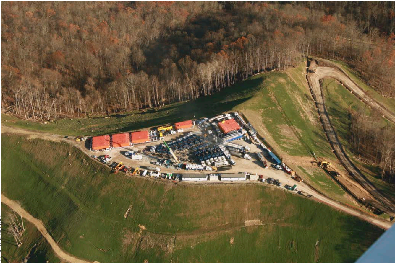
Una explotació d'hidrocarburs mitjançant la tècnica de fracking a Wetzel County, a Virginia de l'Oest, EUA.
