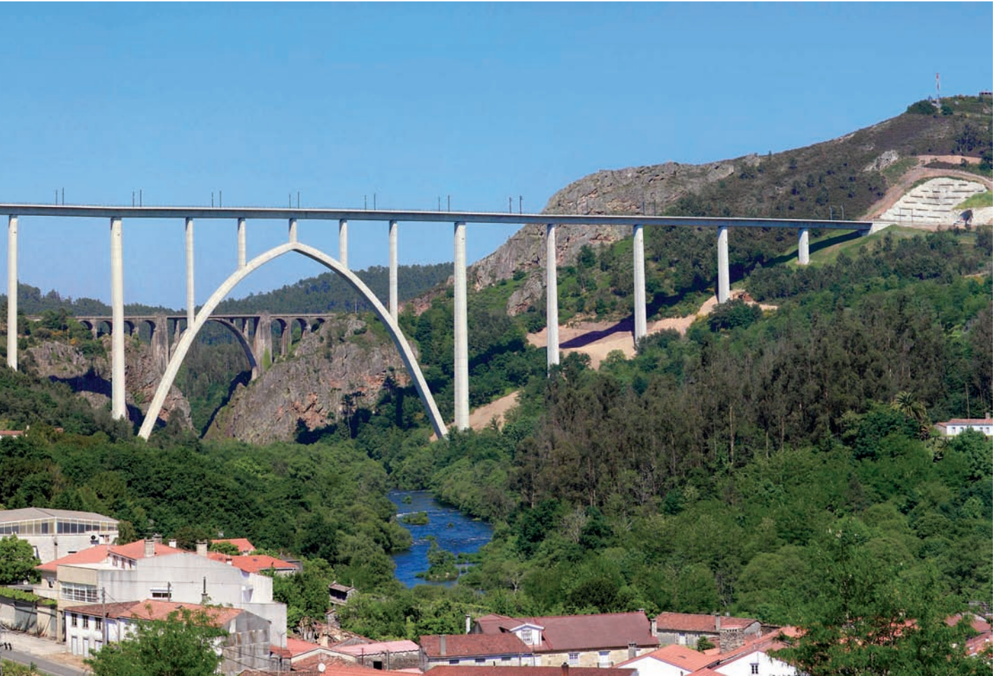
lades al TGV espanyol: el viaducte de 630 metres que s'ha construït perquè el tren de gran velocitat que va a Galícia travesse el riu Ulla.
