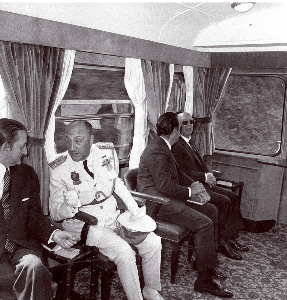
tren de Renfe que fa la ruta Ferrol-Gijón, el setembre del 1972, acompanyat de dos ministres.
