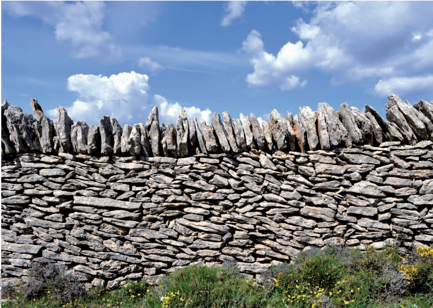
Una paret de pedra seca a Vilafranca (Ports) i una falsa volta característica de les barraques alçades amb aquesta tècnica constructiva.
