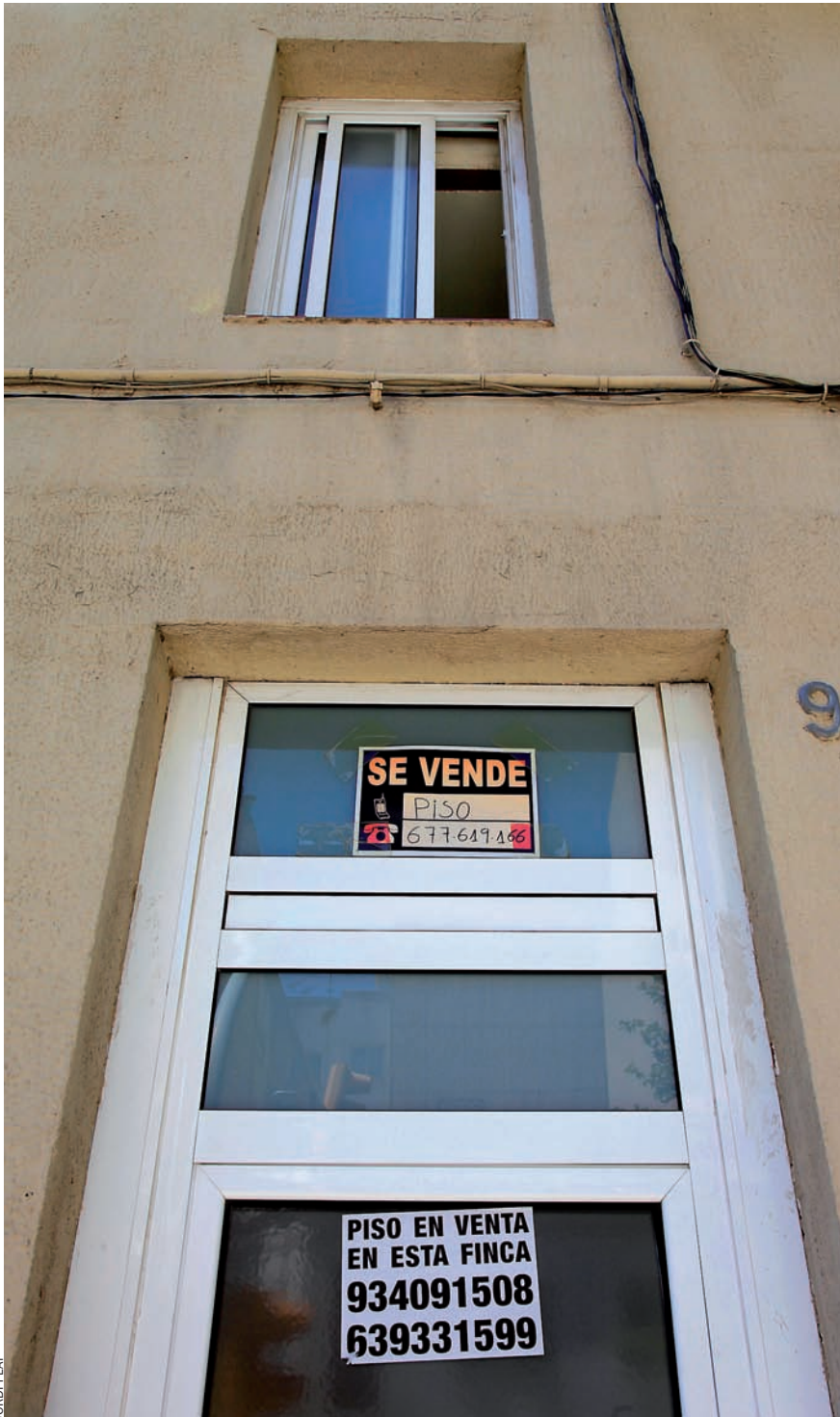
Els Països Catalans acumulen 253.000 habitatges sense vendre. Pis en venda a la zona del Poblenou.
