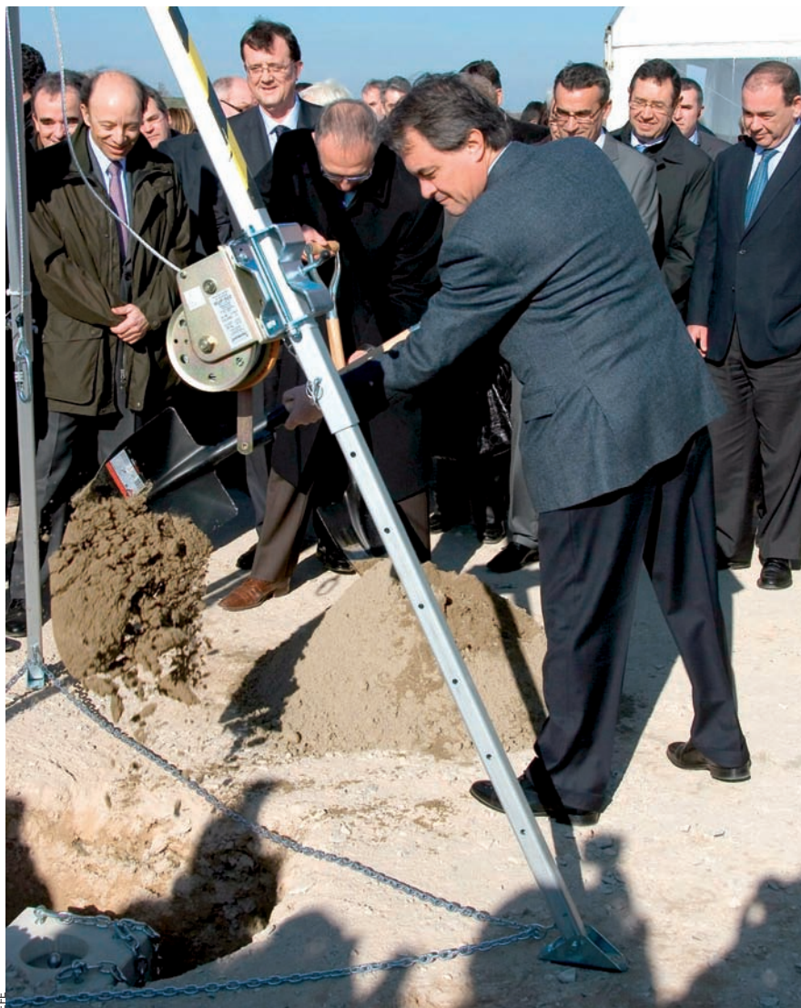
Catalunya tindrà la primera instal·lació mundial que combinarà la tecnologia solar termoelectrica amb una unitat de biomassa, a les Borges Blanques, amb una potència instal·lada de 22,5 MW.
