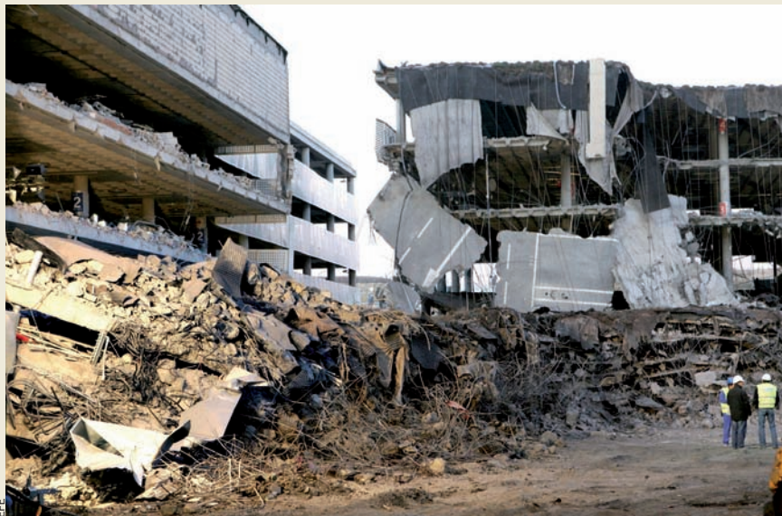
Final de desembre del 2006. L'explosió d'una furgoneta carregada d'explosius feia dos morts i destruïa el pàrquing de la terminal 4 de l'aeroport de Barajas.
