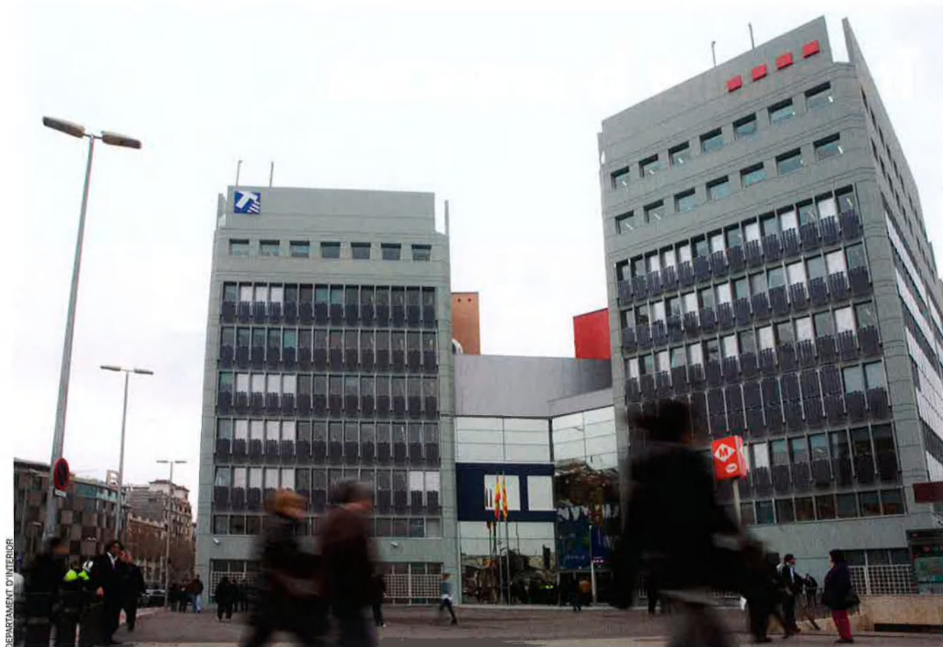
Comissaria dels Mossos d'Esquadra a la plaça d'Espanya de Barcelona (Inaugurada el 4 de gener d'enguany). La comissaria, la més gran de Catalunya, té instal·lades a les dues façanes principals una superfície de 380 metres quadrats de plaques solars.
