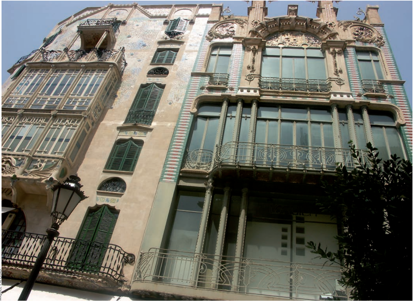
L'edifici de l'Àguila, de Gaspar Bennàssar, al centre de la ciutat, devora la plaça Major.
