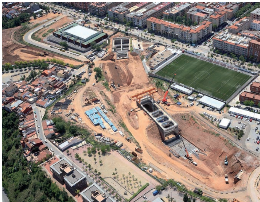
Parc del Nord de Sabadell, on també es perllongarà la línia del Vallès dels FGC.
