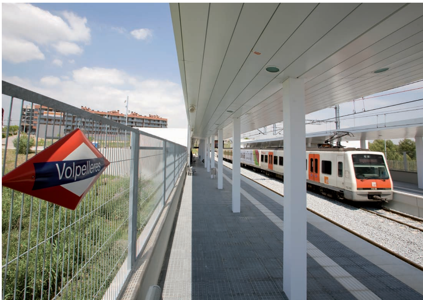
Volpelleres és ja la setena estació dels FGC al terme municipal de Sant Cugat del Vallès.
