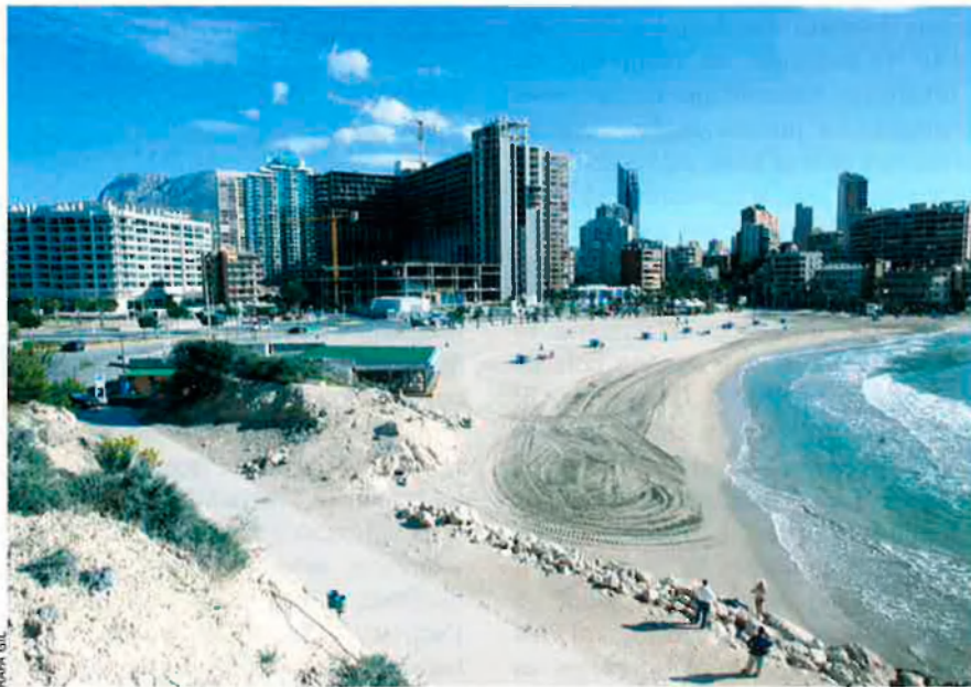
La construcció de l’edifici Atrium, a Benidorm (Marina Baixa), ha resultat afectat per la crisi.
