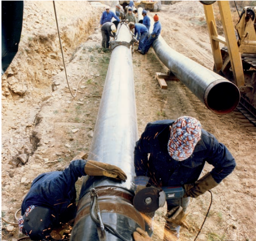
Construcció d'una canonada de gas. L'Estat espanyol és un dels països europeus amb un proveïment de gas més diversificat, al contrari que la UE, que depèn excessivament de Rússia.
