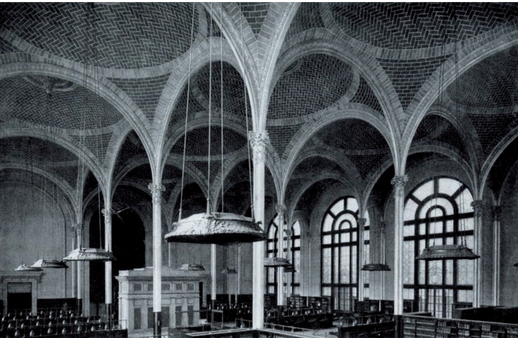
Voltes de la biblioteca de l'edifici de l'Albany State Education (a l'estat de Nova York), construït per Rafael Guastavino entre els anys 1910 i 1911.
