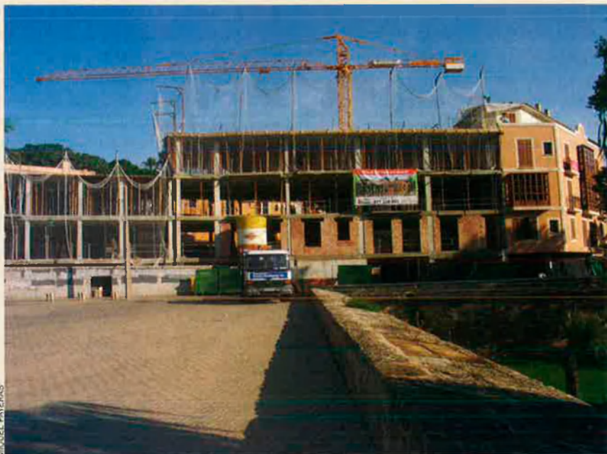
Construcció d'un bloc de pisos a la ciutat de Palma.
