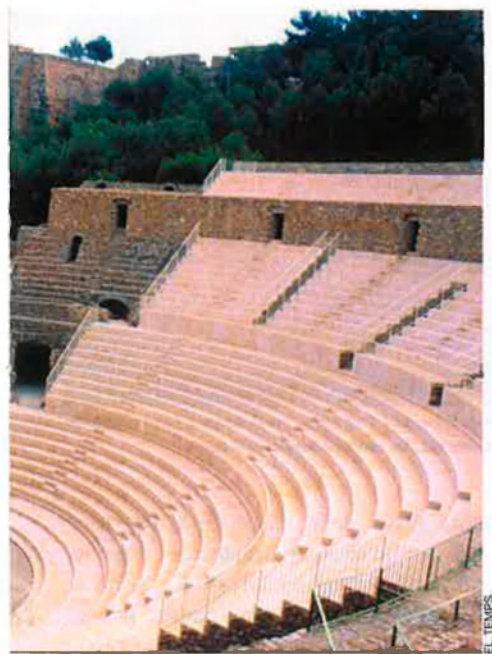
Situació del teatre romà de Sagunt abans i després de la intervenció feta entre el 1990 i el 1993 pels arquitectes Giorgio Grassi i Manuel Portaceli.
