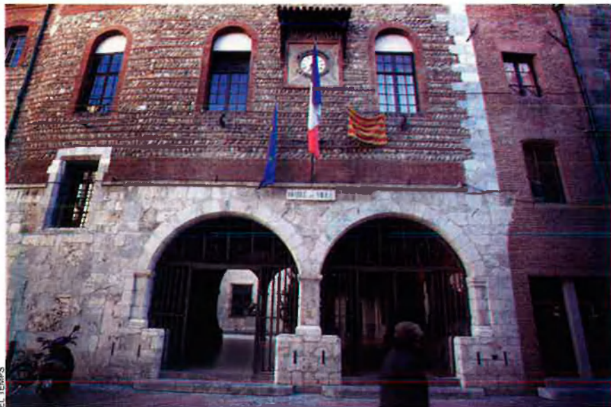
L'Ajuntament de Perpinyà ha recorregut al partenariat per construir la futura estació del TGV.
