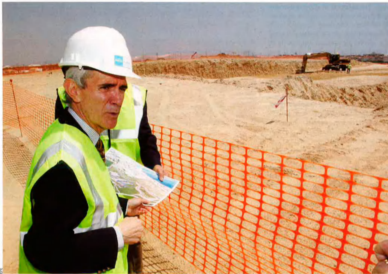
El president d'Acuamed, Adrián Baltanás, visita les obres de la dessaladora de Torrevella, que s'ha d'haver acabat a final de l'any vinent.
