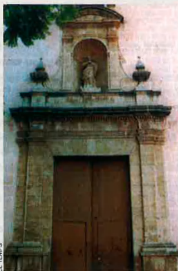
Façana de la nova església parroquial de Santa Maria, de Dénia.
