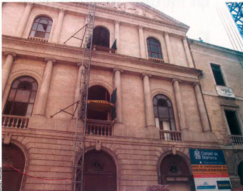
Les obres més costoses del Teatre Principal de Mallorca, les d'estructura i infraestructura, ja s'han acabat.
