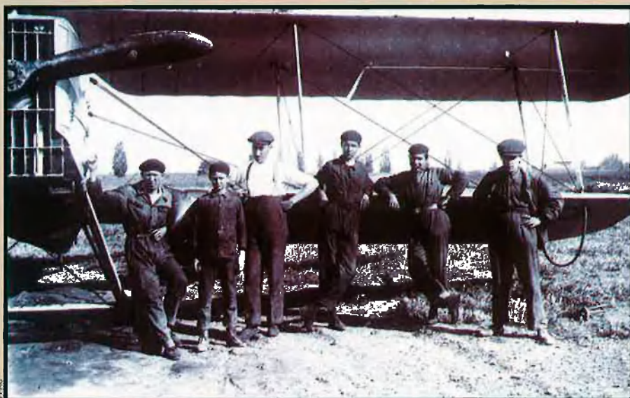
Mecànics davant d'un Breguet XIV, un biplà clàssic: estructura de fusta revestida de tela.
