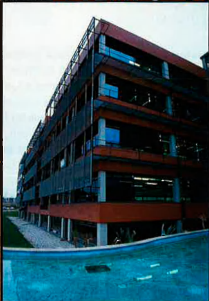
Aquest edifici de la Universitat de València acull la seu de l'Institut Cavanilles.
