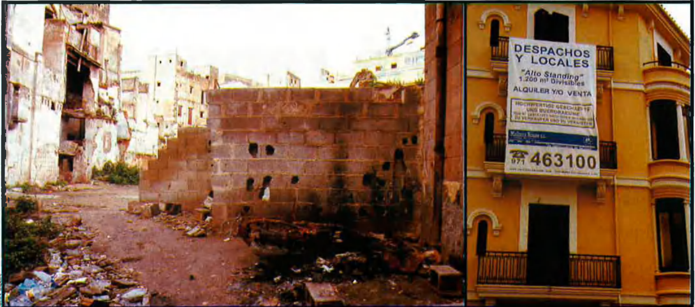
Dos punts de vista de la ciutat antiga de Palma. A l'esquerra, una mostra de deixadesa urbana absoluta. A la dreta, nous pisos construïts per a la venda de màxim nivell econòmic que, en moltes ocasions, adquireixen els alemanys. La rehabilitació potencia aquest negoci.
