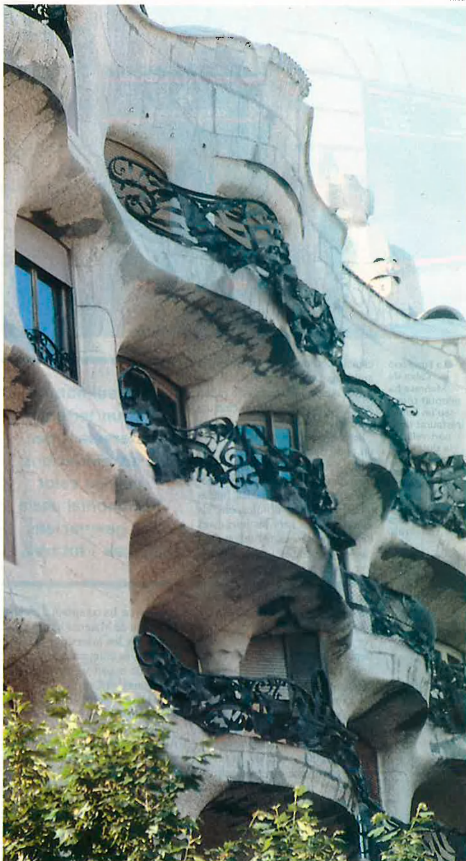
Façana de la Pedrera d'Antoni Gaudí, seu de la Fundació Caixa de Catalunya. Aquest edifici ha esdevingut la insígnia de l'entitat i té una de les sales d'exposicions més visitades.
