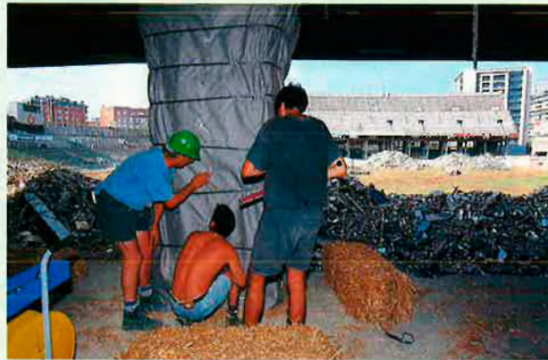
Un grup de treballadors preparen forats als pilars. Aquí col·locaran els quasi cent quilograms de goma-2.
