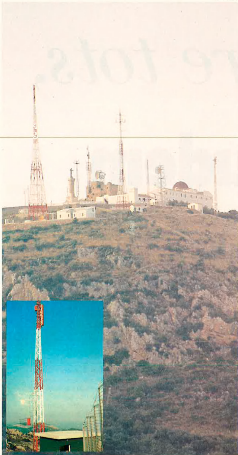
Repetidor de TV3 al Toro (Menorca), i en la imatge petita, el repetidor de Mallorca. L'any 1984, "Volem TV3" fou una reivindicació massiva.
