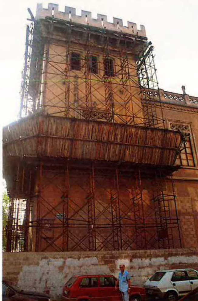
El Palau de l'Exposició, un dels pocs edificis modernistes singulars de València. Espera de fa molts anys alguna ocupació que justifique una intervenció a fons.
