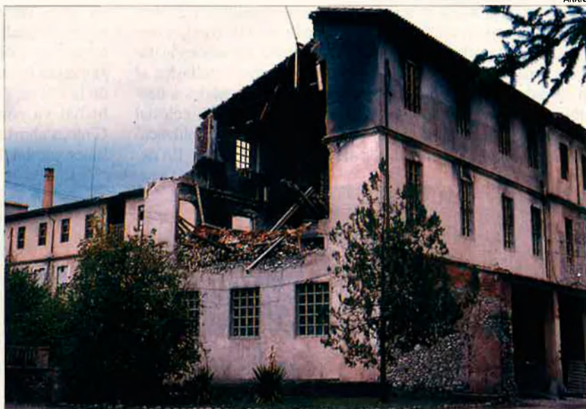
Can Llanas, o Hilandera, SA, de Manlleu. Futura depuradora.
