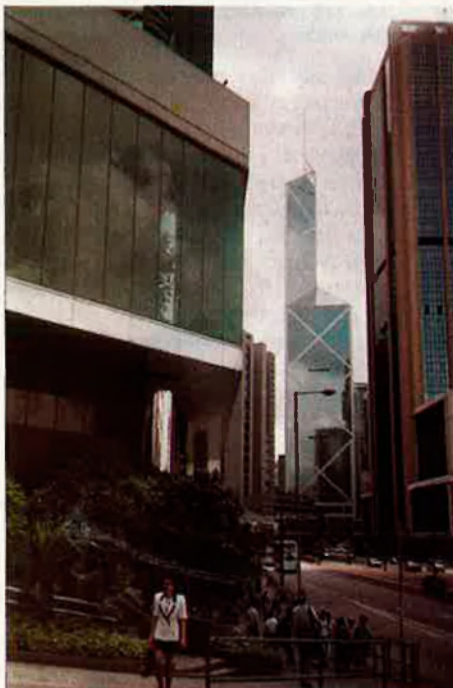
L'edifici més gran d'Àsia és la torre del Banc de Xina, situat al centre de Hong Kong. A. PUNSO LA
