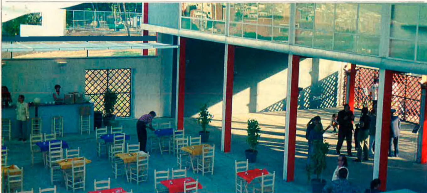
La utilització d'aquest edifici no està decidida encara, però té molts pretendents.
