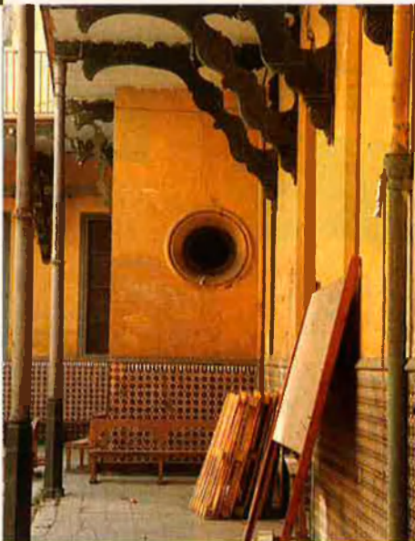
Detall de l'arquitectura dels patis i passadissos.
