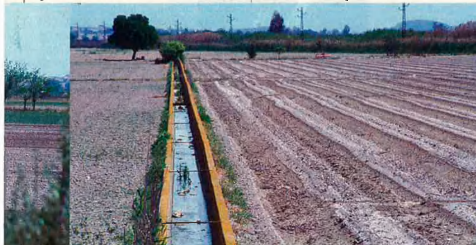
El regadiu del sud necessita més aigua. A la dreta, Embassament del Fondo d'Elx.
