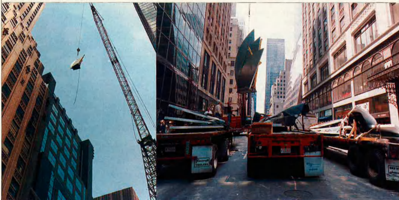
Esquerra, la grua situa una peça sobre l'edifici. Dreta, el carrer 53 va estar tallat al trànsit durant dos dies.
