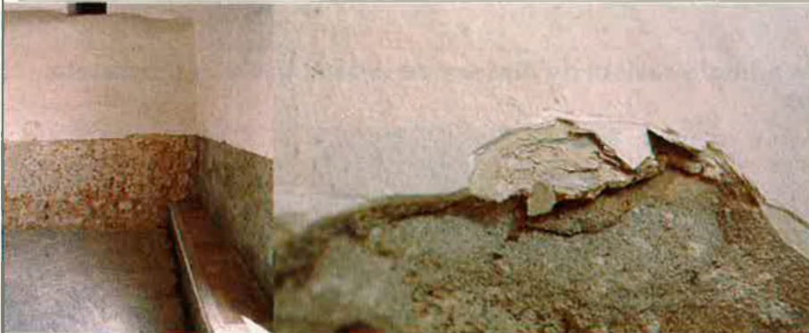
A l'esquerra, sobre el banc del porxo ja s'ha posat ciment. Dreta, les capes de calç que s'han anat superposant s'arranquen a cops de martell i se substitueixen per ciment portland.
