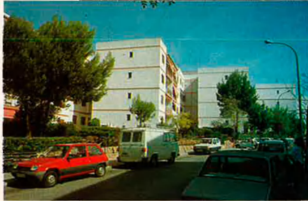
Les cases de Los Almendros estan mal construïdes.
