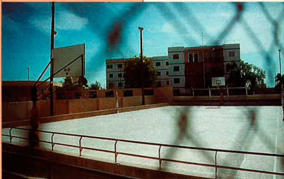
La urbanització Los Almendros presenta algunes irregularitats. PERE CARMONA
