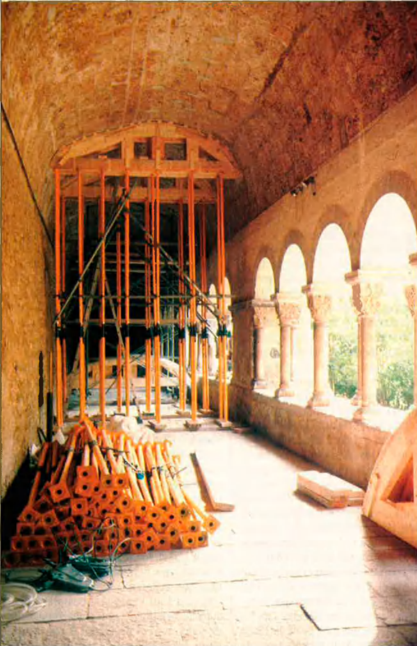
A l'esquerra, part del sostre de volta del claustre romànic, ja apuntalat. A la dreta, dalt, taulons i estructures de fusta i barres de ferro a punt de col·locar. Al centre, condicionador d'aire al claustre de la primera planta. Baix, columna recoberta de plàstic.
