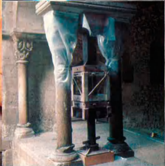
A l'esquerra, part del sostre de volta del claustre romànic, ja apuntalat. A la dreta, dalt, taulons i estructures de fusta i barres de ferro a punt de col·locar. Al centre, condicionador d'aire al claustre de la primera planta. Baix, columna recoberta de plàstic.
