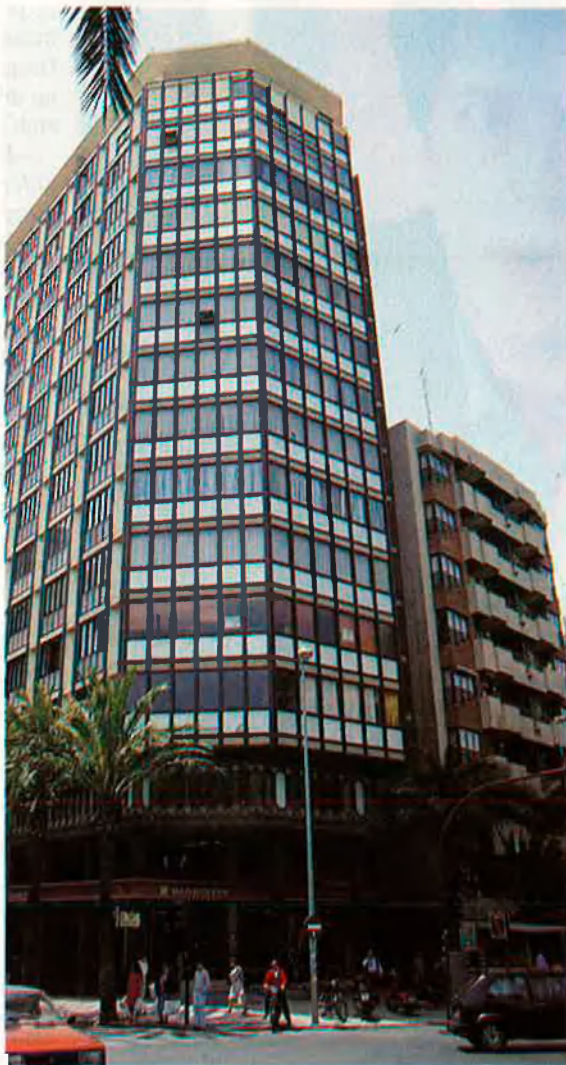
Edifici on hi ha la seu de l'empresa Alacantina.
