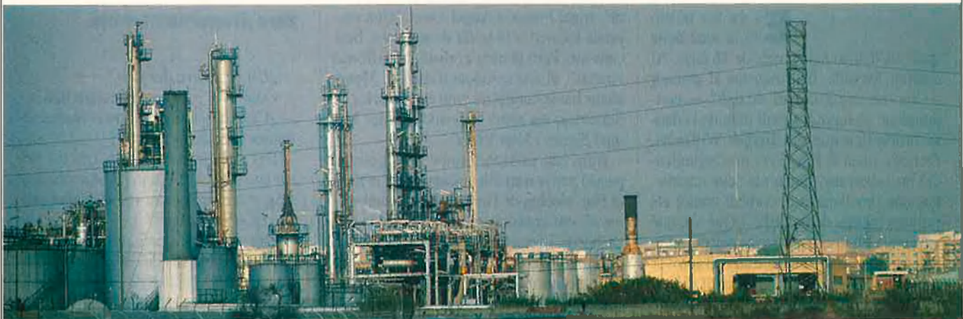
Instal·lació de la IQA a Tarragona.
