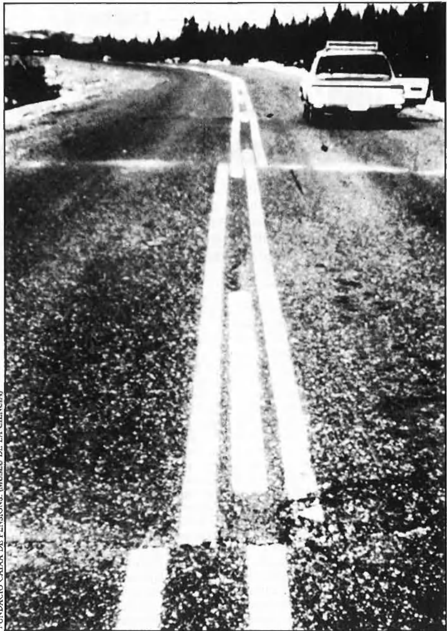
Ratlles desalineades en una carretera d'Alaska després d'un terratrèmol.
