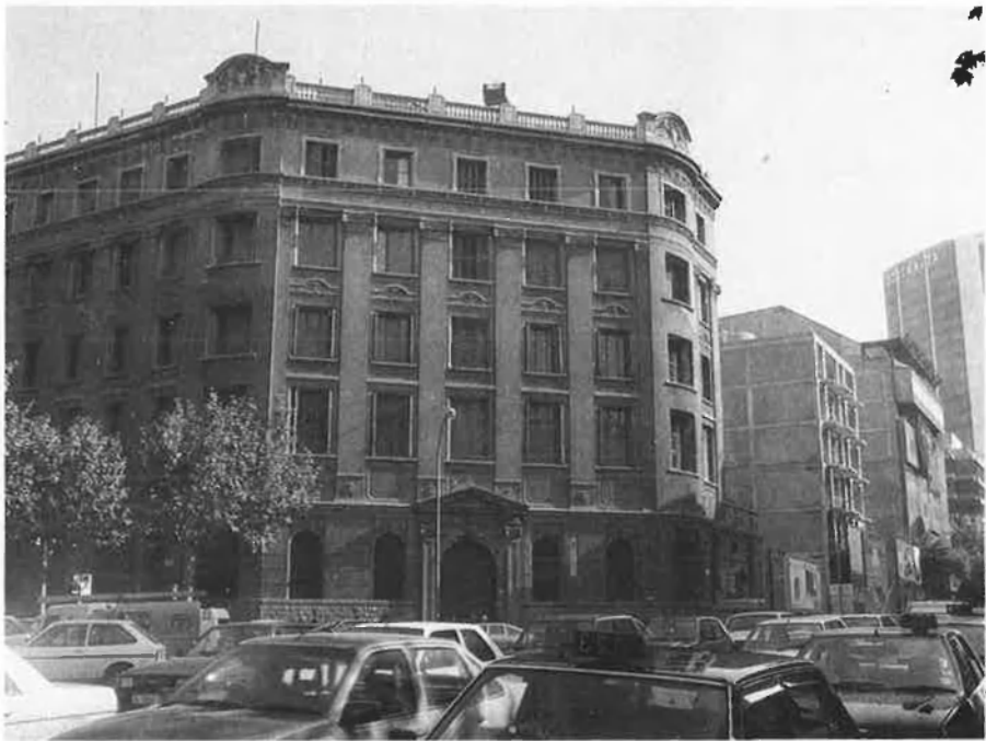
Edifici Fòrum Vergés, destinat a hotel de 4 estrelles.
