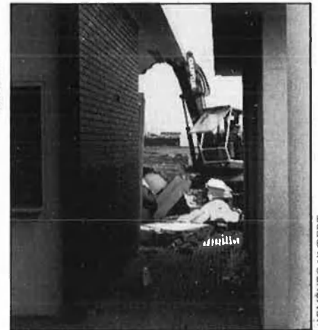
Enderrocament d'un edifici del Ministeri de Defensa a Castelldefels.
