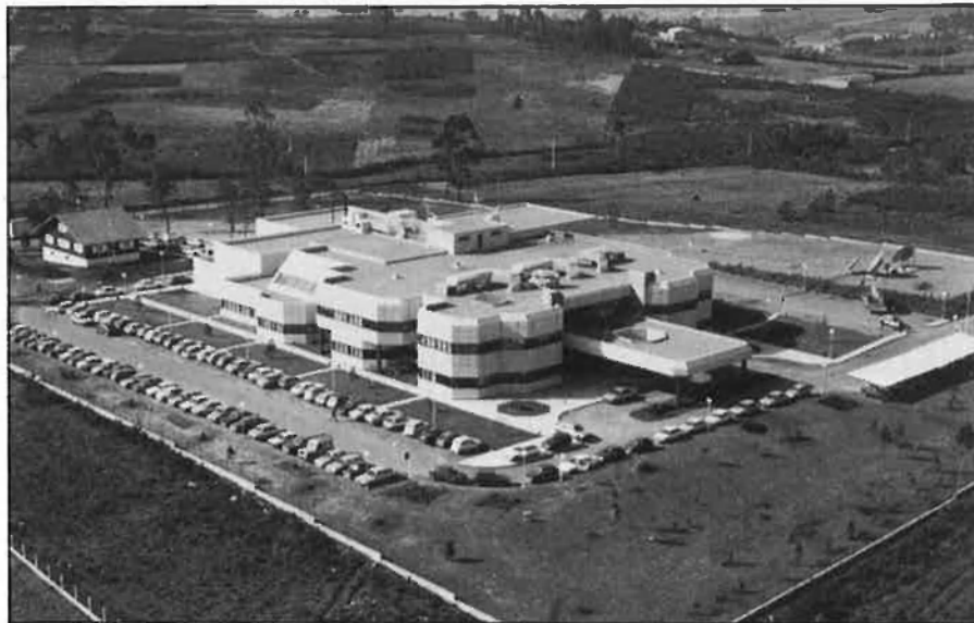
Instal·lacions de TVG.
